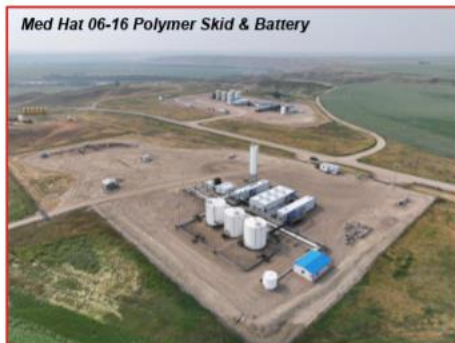
Med Hat 06-16 Polymer Skid & Battery
